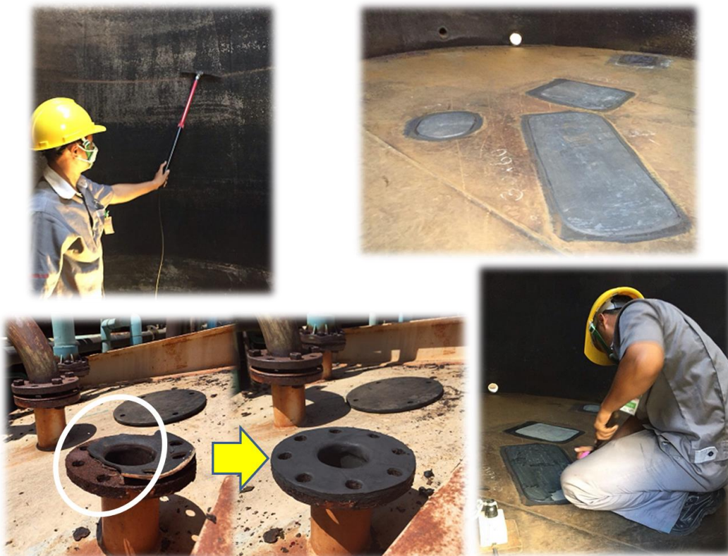
写真上左：ピンホールテスト、上右：底板補修完了、下左：配管フランジ部欠損を元通りに補修、下右：底板補修作業中
