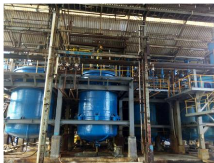
今回施工完了のリアクタータンク
